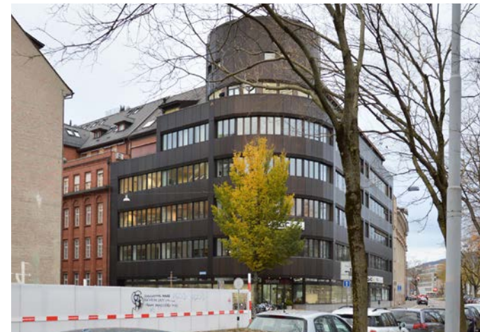
Metallfassade von 1979, Dachsanierung 1990
