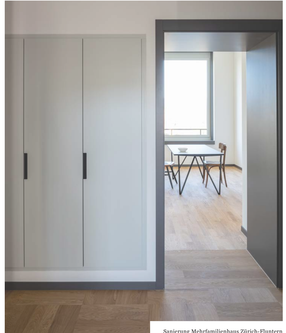
Sanierung Mehrfamilienhaus Zürich-Fluntern
